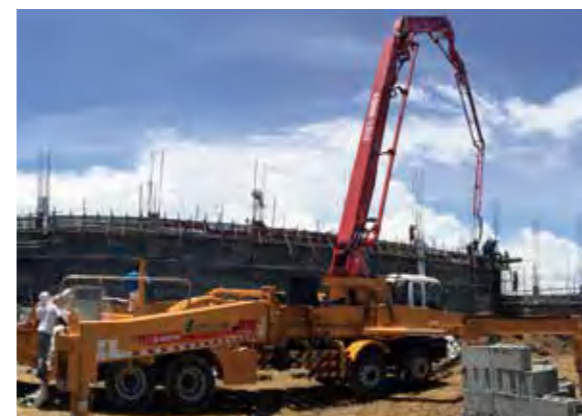
徐工混凝土兄弟助力菲律宾物流园建设 XCMG concrete brothers help Philippine construction
